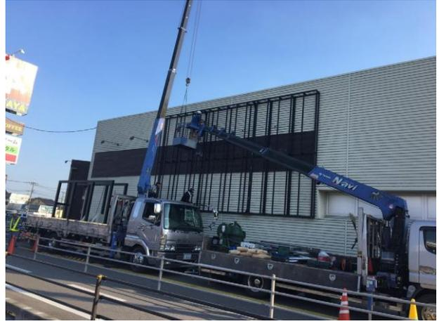
クレーン車を用いた下地設置
