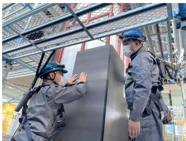
フルハーネス装着義務の高所作業の徹底
