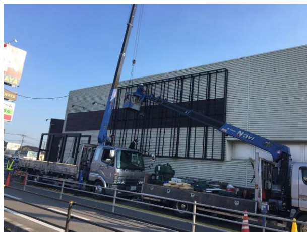
クレーン車を用いた下地設置
