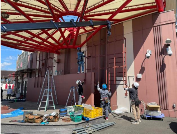
取付下地設置
