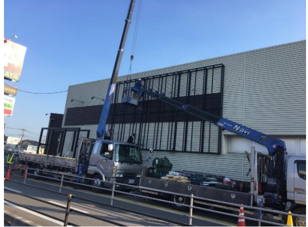
クレーン車を用いた下地設置
