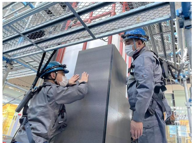
フルハーネス装着義務の高所作業の徹底
