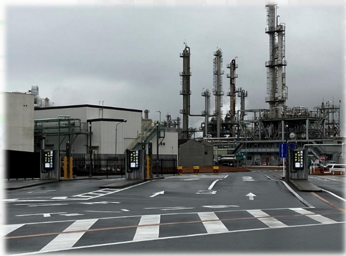
工場搬入口にて活用された事例
